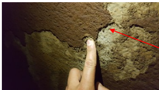
Parede do reservatório
